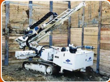
France - Anchor Hole Drilling \phi 114.3\text{mm} Frankreich - Ankerbohren \phi 114.3\text{mm}
